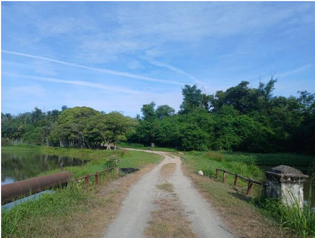
Jambatan lama Jalan Ayer Itam, menghala ke barat (Puchong). (Sumber: TMK Pulasan, 2025).
