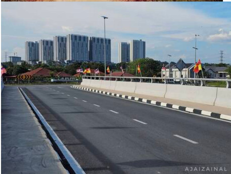
"Jambatan Sungai Buah dahulu
