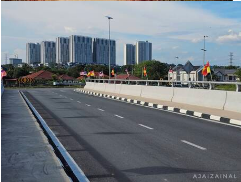
"Jambatan Sungai Buah dahulu
