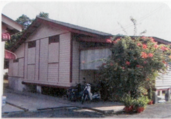
Rumah Ketua Kampung Desa Putra yang dahulunya merupakan rumah Penyelia Tanah Rancangan masih dikekalkan hingga kini.
