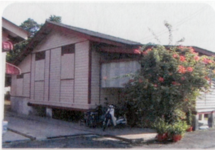
Rumah Ketua Kampung Desa Putra yang dahulunya merupakan rumah Penyelia Tanah Rancangan masih dikekalkan hingga kini.
