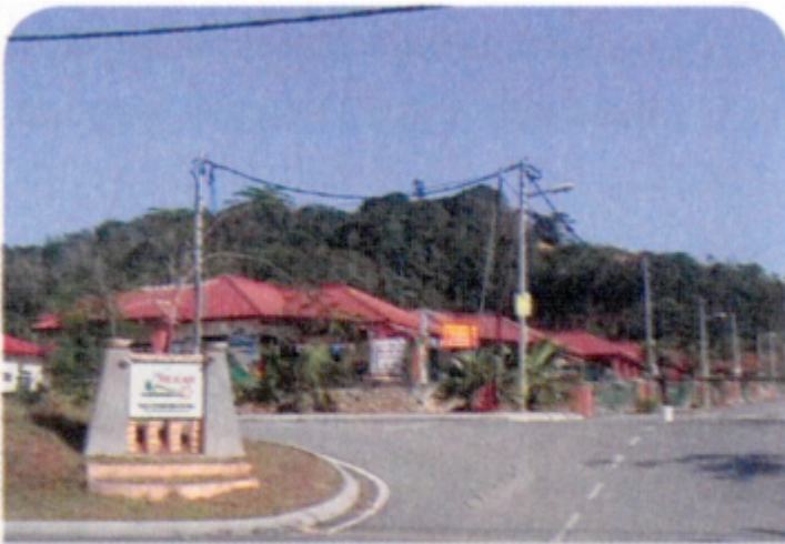
Taman Desa Mekar merupakan antara taman perumahan yang dibina di Kampung Desa Putra.
