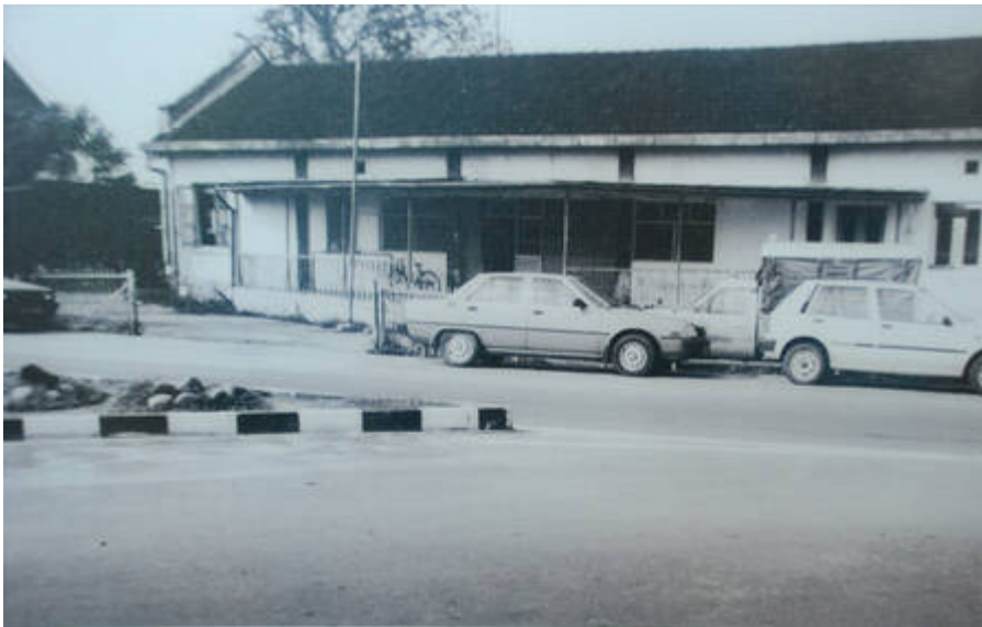
"Bangunan lama Lembaga Letrik Negara (LLN) Kajang pada tahun 1983. Bangunan ini terletak berhampiran Bulatan Kajang." (1983).
