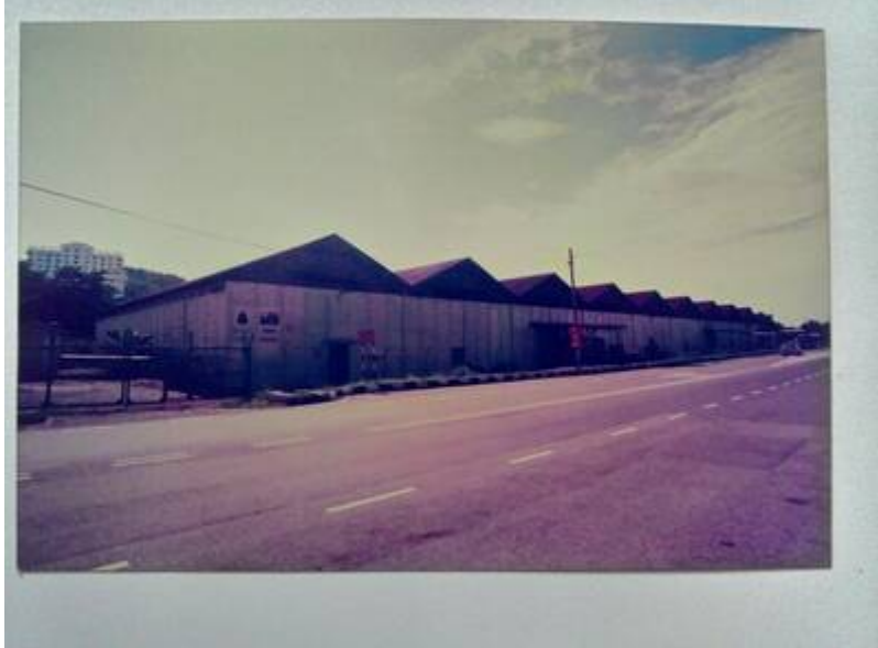
Kiri: "Ini jalan reko lama dari pekan Kajang ke Ukm, lokasi berhampiran pintu pagar keretapi, semasa saya ambil foto ni pagar itu telah tiada kerana kerja2 pengubahsuaian jalan telah bermula. Mustafa Yahya pelukis hulu langat." (Tapa Seni Rimba @ Facebook Bandar Kajang Group, 30 Julai 2017:
