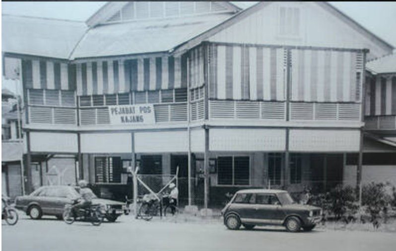
Kiri: "Pada 29 April 1967, Sultan Selangor telah merasmikan stesen pemancar Seberang Laut RTM yang baru di Kajang, Selangor. Ini ialah Pejabat Radio TV Malaysia Kajang yang terletak di Jalan Kelab Selangor." (1987); Kanan: "Pejabat Pos Kajang yang terletak di Jalan Hishammudin." (1985).
