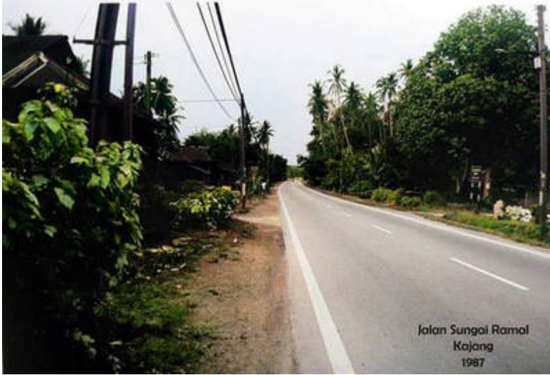
Jalan Sungai Ramal Kajang 1987
