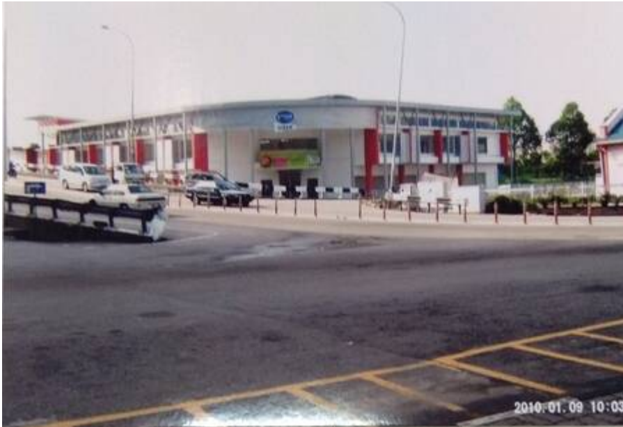
“Bangunan Aked Mara Kajang. Saya menyelia binaan bangunan ini pada tahun 1981. Tapak bangunan Aked Mara ini asalnya pasar Kajang.” Kiri: 1990-an. Kanan: Kini (2010). (Tapa Seni Rimba @ Facebook Bandar Kajang Group, 1 November 2018: " Bangunan Aked Mara Kajang ").
