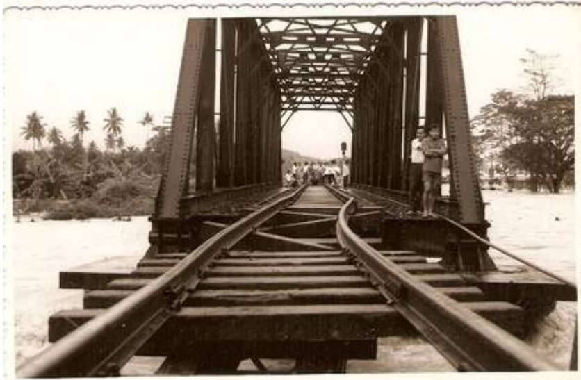
(7) Jambatan keretapi (binaan besi asal, kini konkrit) menyeberangi Sungai Langat, di belakang Arked Mara dan TNB Kajang. Kelihatan landasannya bengkok akibat arus deras.
