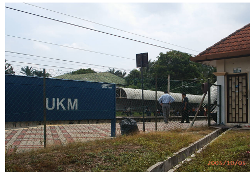
Stesen komuter-LRT UKM (Rawang-Seremban)
