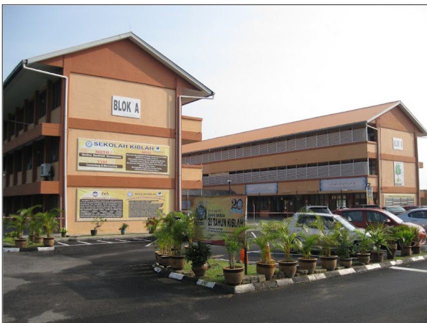
Setelah menempuh berbagai ranjau dan cabaran setelah sekian lamanya, akhirnya tibalah masa Sekolah Kiblah berlabuh ke destinasi yang terakhir. Terletak di Jenderam Hulu bersebelahan Bukit Unggul dan Nur Bukit Unggul, di situlah Kompleks Pendidikan YAKIN dibina
