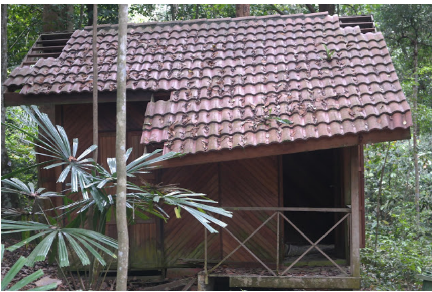
Dulunya ini adalah chalet untuk peserta yang ingin bermalam di dalam suasana hutan UKM, sekarang sudah rosak sepenuhnya dan tidak boleh digunakan lagi.
