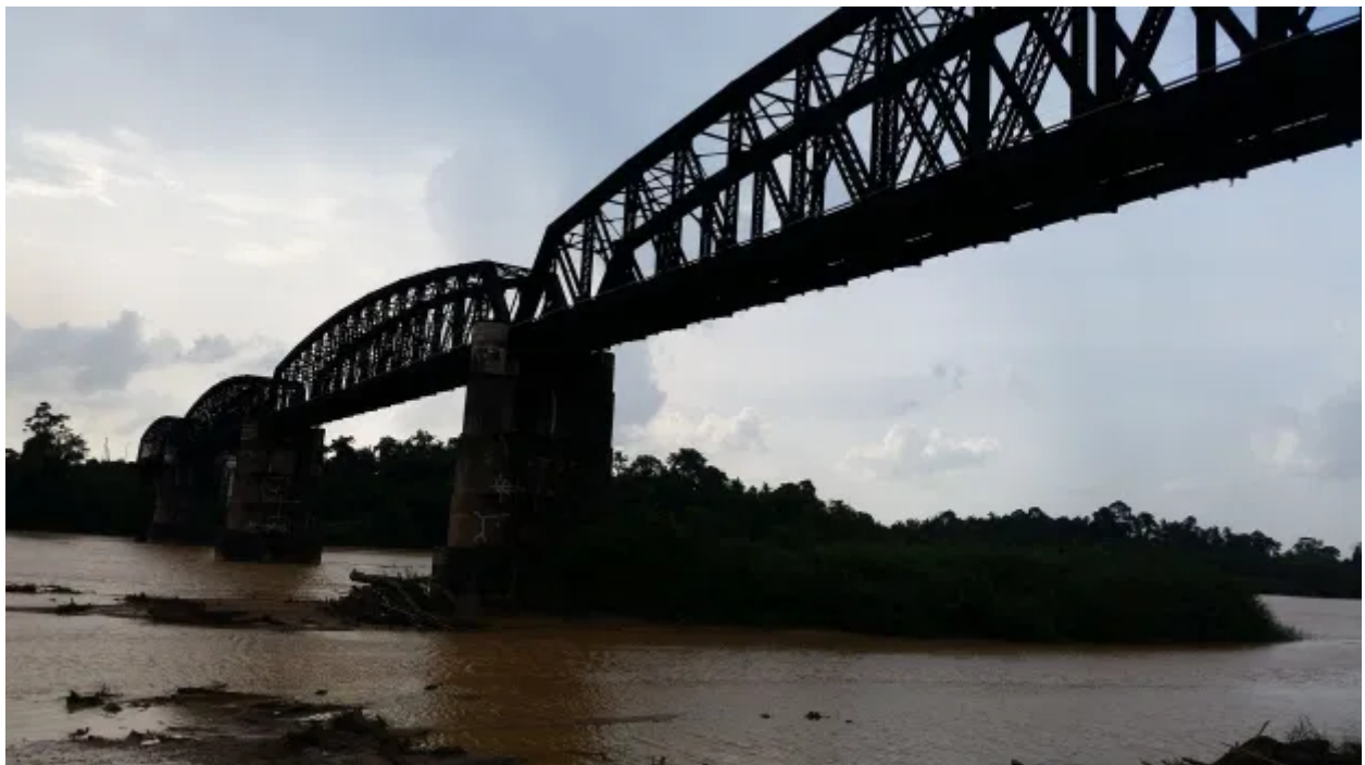
Guillemard Bridge / Photo source : Wikimedia Commons
