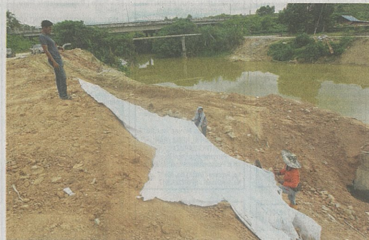
PEMASANGAN kanvas dilakukan bagi mengelakkan runtuhan tebing Sungai Semenyih melarat ke tempat lain.
