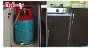
Awat, Boleh 'Meletup'! Ramai Tak Tahu Bahaya Letak Tong Gas Dalam Kabinet Bertutup
